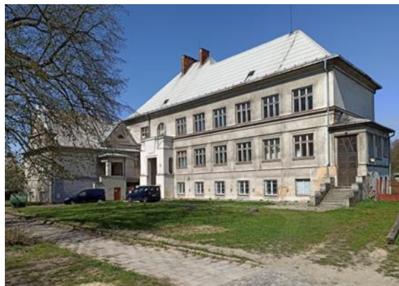
Depozitář v budově na ul. Tovární
